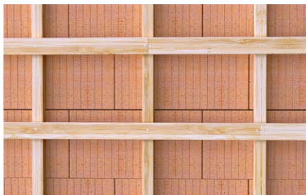
Telai e sottostrutture in legno.
