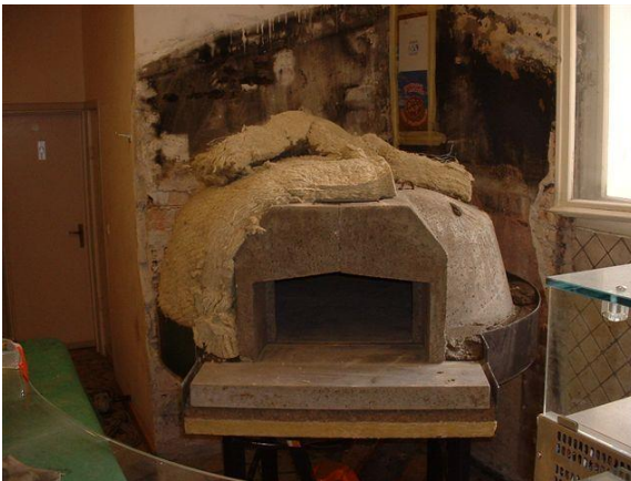
Posizionamento della lana di roccia spessore 10 cm. densità 100 su rete metallica.
